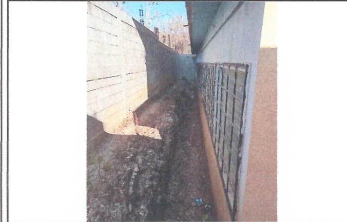
Foto 3: MEJORAMIENTO E INSTALACIÓN DE CUNETAS DE CONCRETO.
